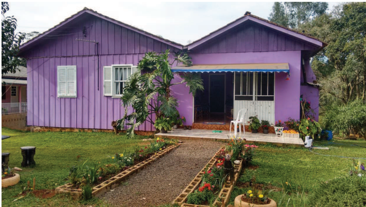
Figura 3: Residência existente na UP da família Guberte, na comunidade Urumbeva
